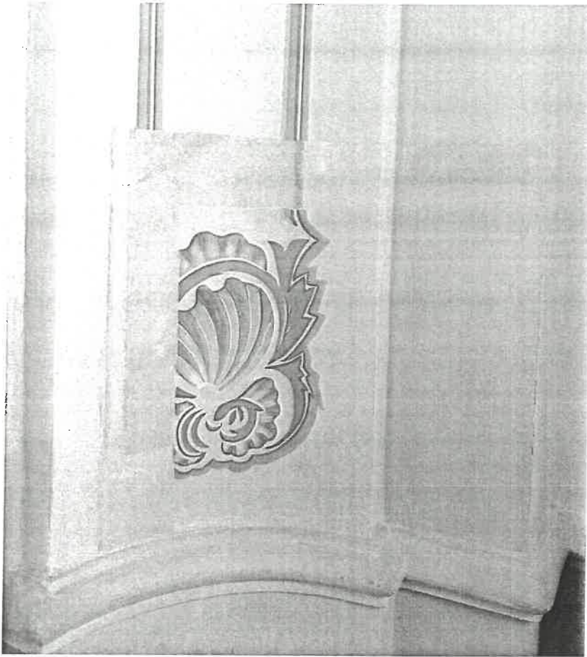
fol. 14. Odkrywka stratygraficzna z widoczną marmoryowaną płytą na pilastrze w kaplicy bocznej
